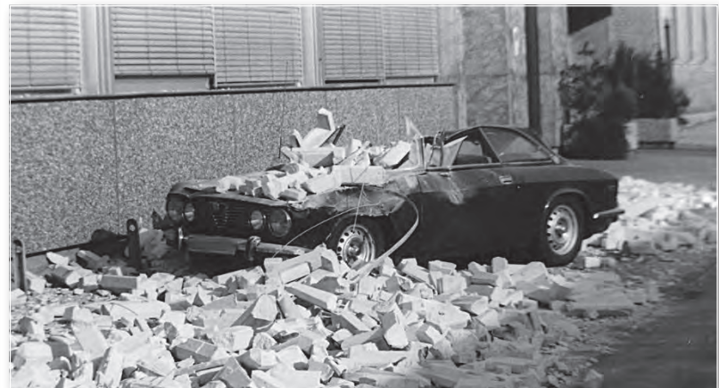
Durch herabfallende Gebäudeteile wurden viele Autos zerstört
