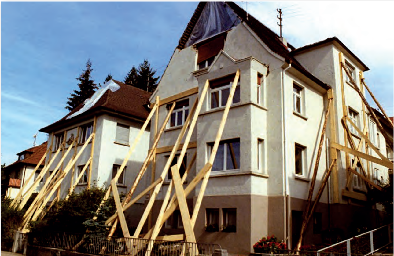
Sicherungsmaßnahmen an Gebäuden nach dem Beben
