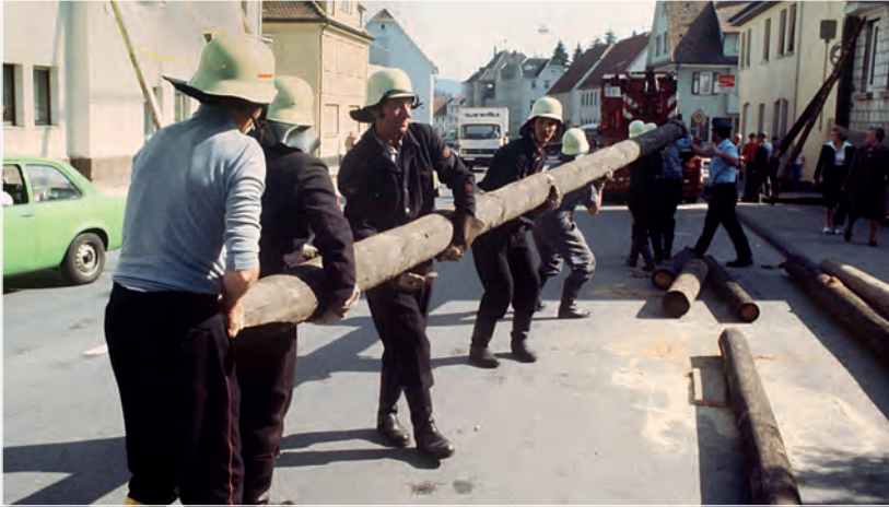
Feuerwehrangehörige bei den Sicherungsmaßnahmen an den Gebäuden
